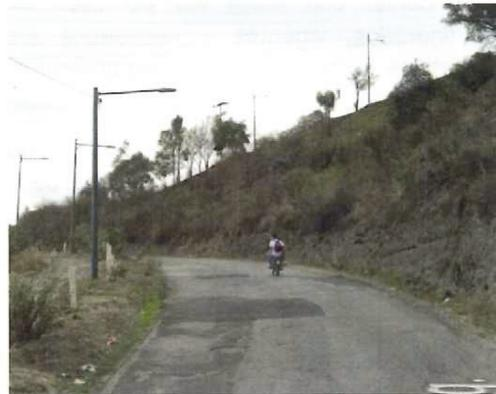
Carpeta Asfáltica en mal estado, presenta agrietamientos y baches.
