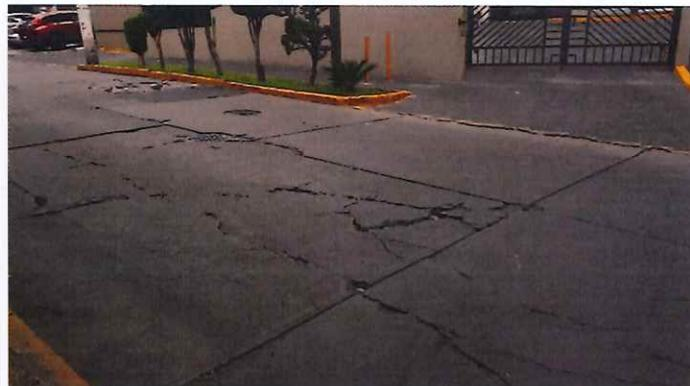
Secciones de concreto dañadas, con fracturas y hundimiento.
