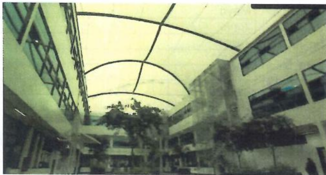
En el patio central se ubican escaleras para el desplazamiento vertical dentro del edificio.
