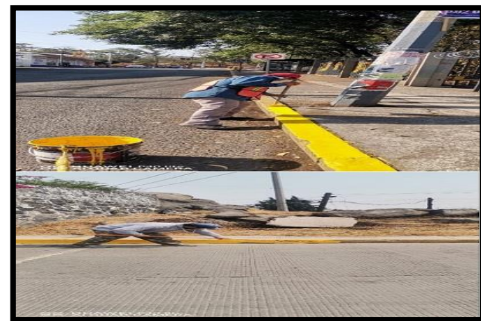
Pinta de guarniciones en calles y avenidas.
