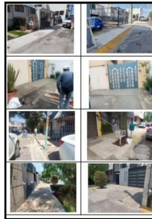
Construcción de banquetas en apoyo a la comunidad.
