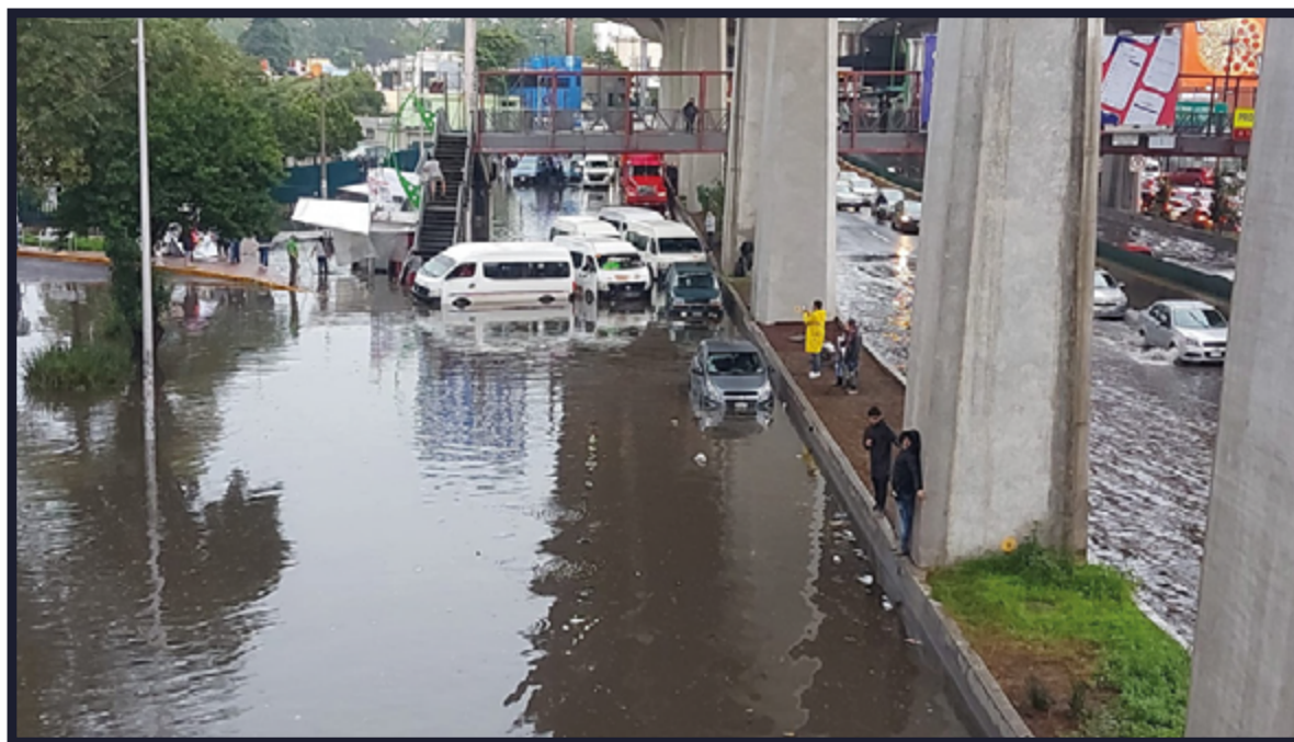
71 Inundación por precipitación pluvial en la zona de El Mirador.
